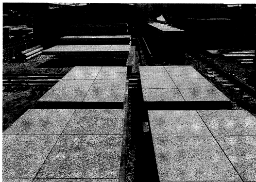
写真-10 パラペットパネル (鹿島建設提供)
