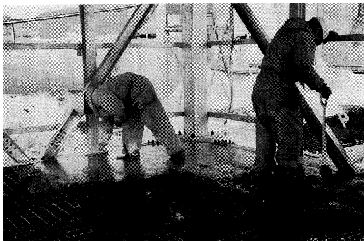
写真-15 床スラブコンクリートの打設（ネフコム提供）
