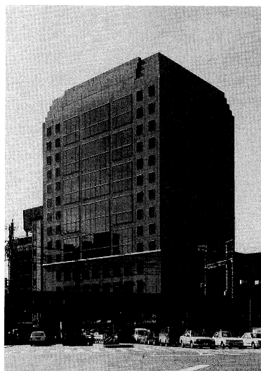
写真-11 東京歯科大学水道橋ビルのパラペット (鹿島建設提供)
