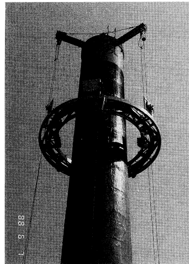
写真-22 既存 RC 煙突の耐震補強(鹿島建設提供)
