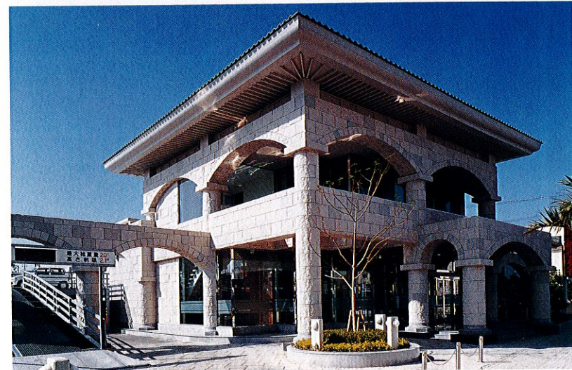
写真11 ステーション真栄原新築工事〔1. 国建, 2. 共和産業, 3. 旭硝子〕
