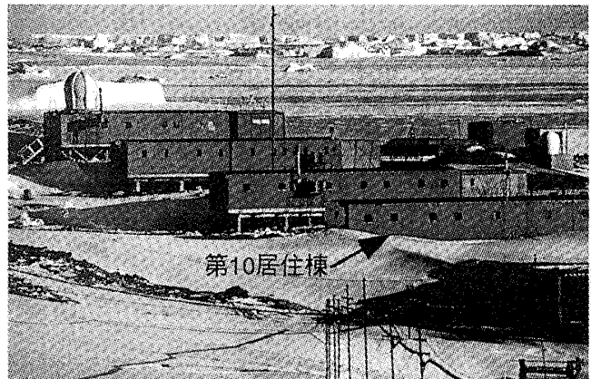
図1 昭和基地居住施設
